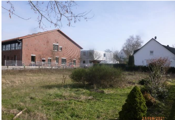
Abb. 11: Blick auf die Grundschule in östlicher Richtung
