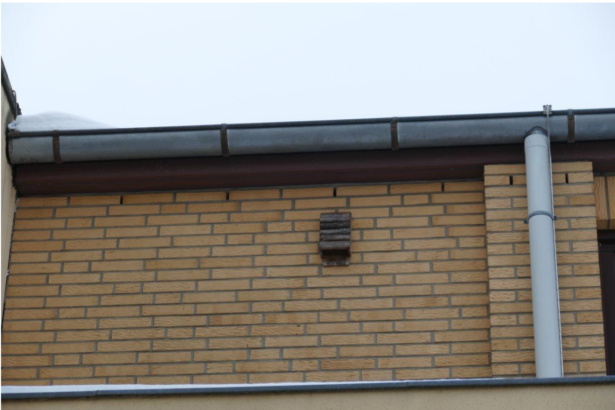
Abb. 8: Blick vom Innenhof auf die Außenwand des Südflügels mit auf Höhe des Obergeschosses montiertem Fledermauskasten sowie mehreren Lüftungsschlitzen (besonders auffällig neben dem Fallrohr rechts im Bild; Blickrichtung Süd; Aufnahme vom 03.02.2026).
