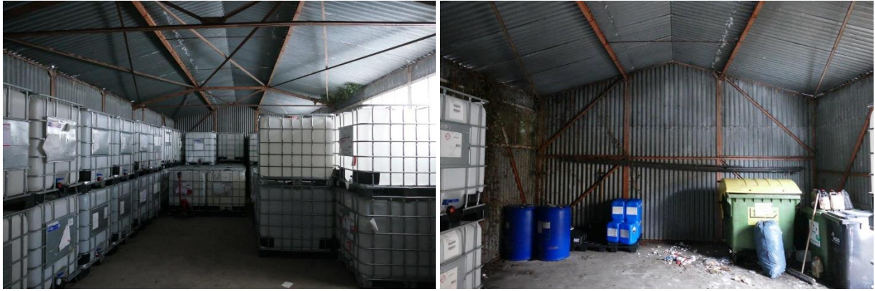
Abb. 13a+b: Innenansichten des Schuppens, bei denen gut die einfache Konstruktion ohne innere Isolierung zur Geltung kommt, die eine Winterquartiersnutzung durch Fledermäuse ausschließt (Blickrichtung Nordwest (links) bzw. Südost (rechts); beide Aufnahmen vom 03.02.2026).
