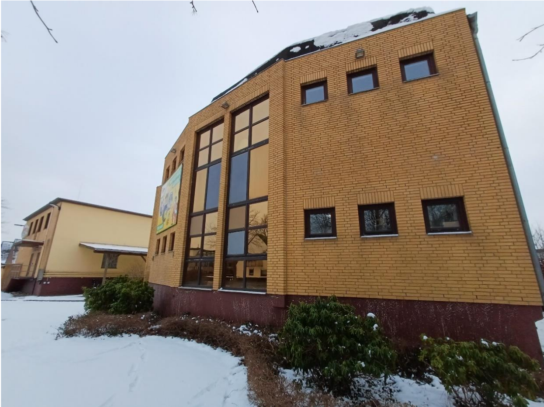
Abb. 1: Südlicher Gebäudeflügel des Poliboy-Firmensitzes (Blickrichtung Nordost; Aufnahme vom 03.02.2026).
