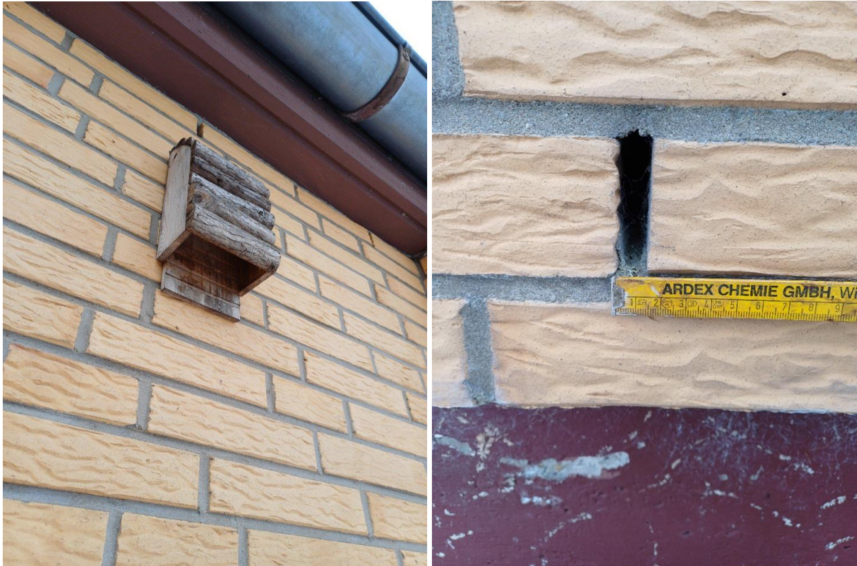
Abb. 9a+b: Nahansicht des am Gebäude montierten, zum Untersuchungszeitpunkt unbesetzten Fledermauskastens (links, Blickrichtung Südwest) sowie im unteren Bereich der Außenwand in gut anderthalb Metern Höhe gelegener Lüftungsschlitze am Südflügel des Poliboy-Gebäudes (Blickrichtung Nordost; beide Aufnahmen vom 03.02.2026).
