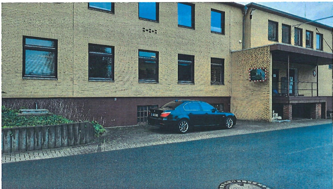
Abb. 2: Situation im Bereich des Ansatzpunktes BS 2, südwestliche Blickrichtung
