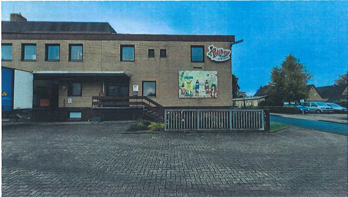
Abb. 3: Situation im Bereich des Ansatzpunktes BS 3, nordwestliche Blickrichtung
