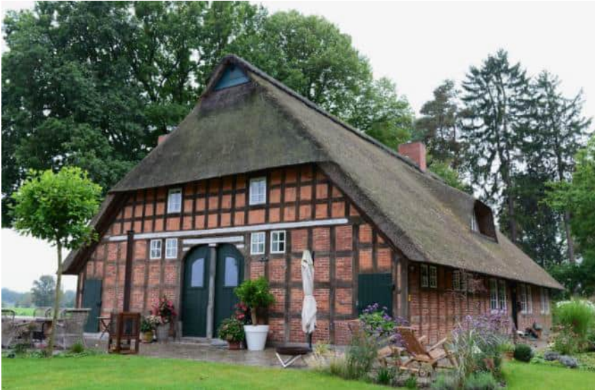
Abb. 27 Nordost- und Nordwestfassade (2021) (Albert Gerdes)
