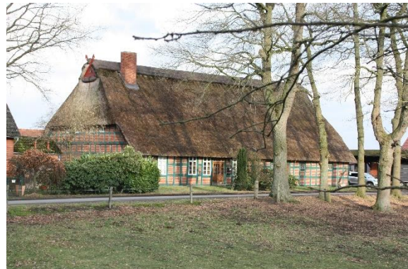
Abb. 8: denkmalgeschütztes Gebäude Bergstraße 5
