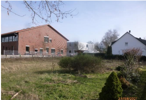
Abb. 11: Blick auf die Grundschule in östlicher Richtung
